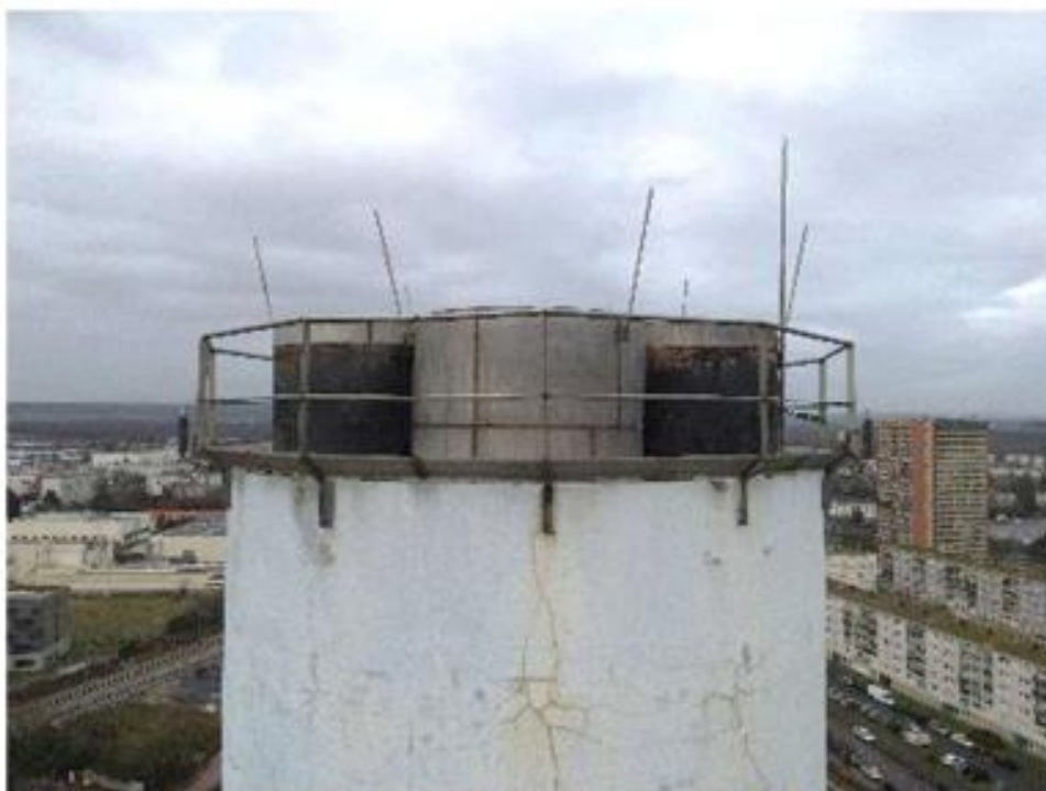
Photo n°3 : Fissuration importante du béton sur environ 1.5m de hauteur et sur 360°
