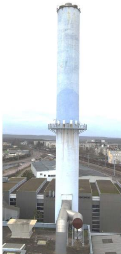
Photo n° 1 : Cheminée vue d'ensemble
