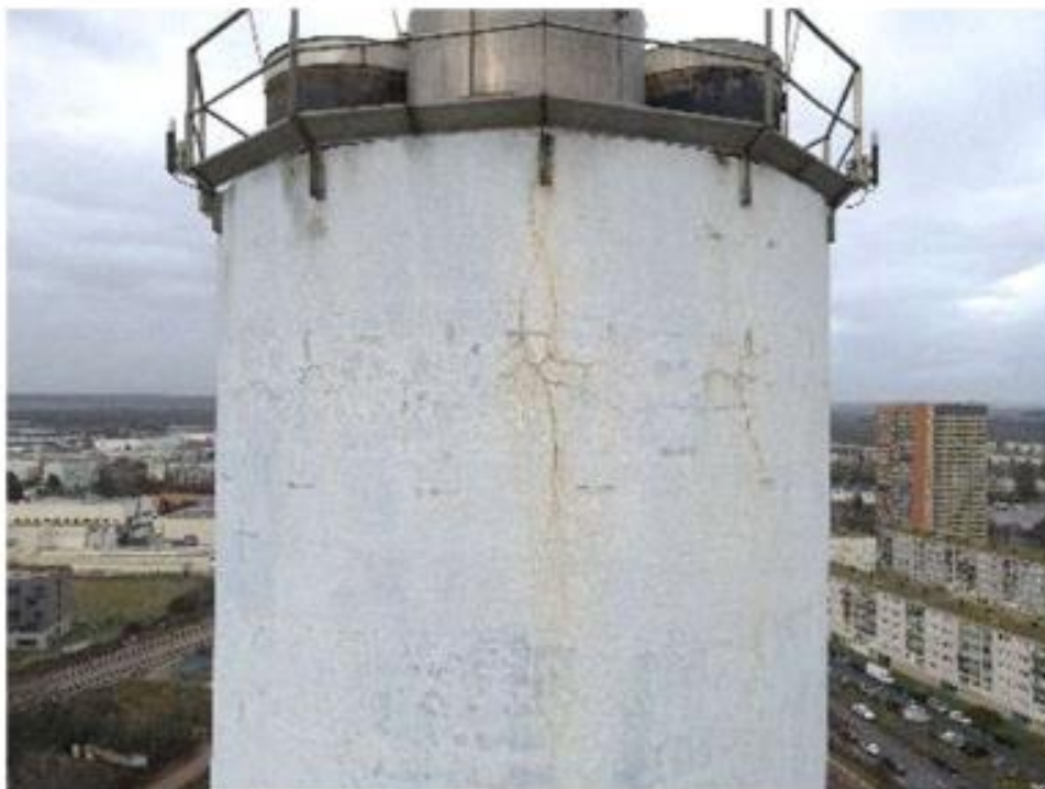
Photo n°2 : Fissuration importante du béton sur environ 1.5m de hauteur et sur 360°
